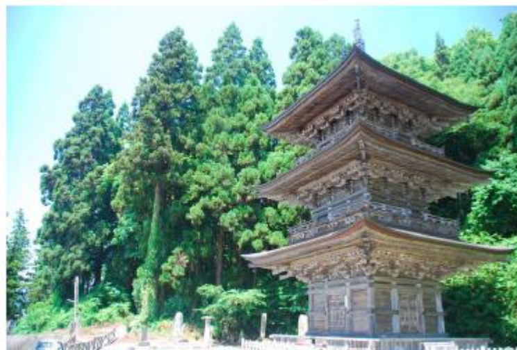
慈恩寺 三重塔
